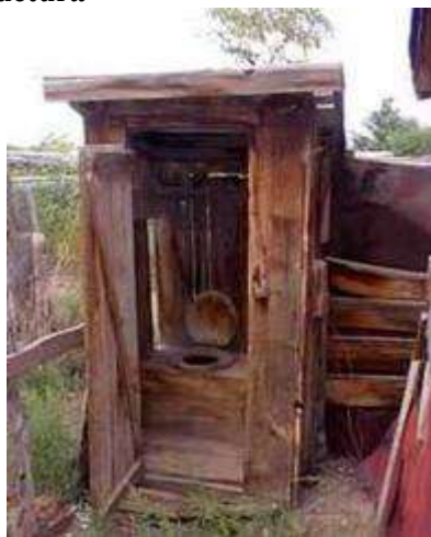
Letrina de pozo seco abierto o sin losa (hoyo sin estructura)
